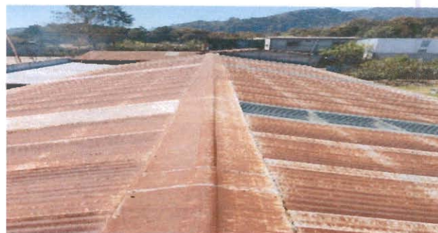
Foto 4: Techo de lámina.
